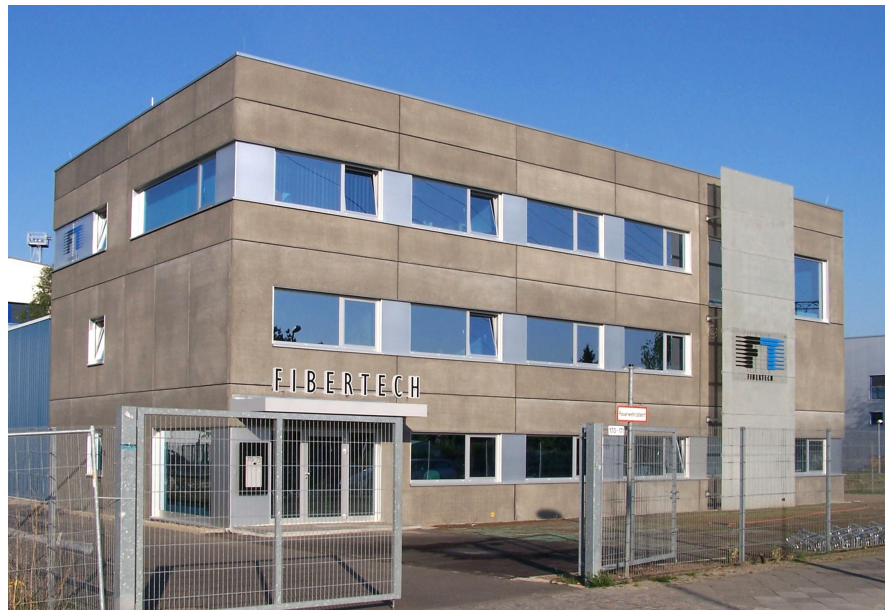
Baukörper errichtet in Fertigteilbauweise mit Oberflächen aus gesäuertem Beton
