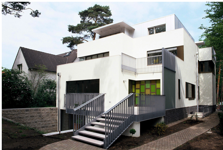
Gartenterrasse mit farbig gestalteten Gartenfenstern
